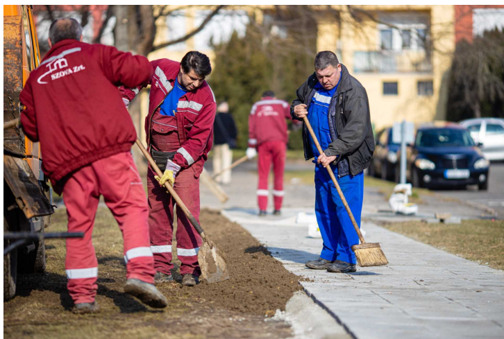
Építik a betonlapos járdát fotó: Bonyhádi Zoltán
